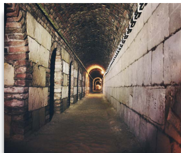
GALERIE DE LIAISON DE WALDECK À DRENTHE
